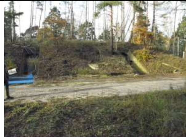
Bereich der Bunkeranlagen.
