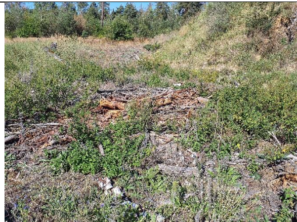
Abbildung 7: Weitere Stelle mit Totholz und Rindenstücken vor dem Erdwall. Foto vom 06.09.2023.
