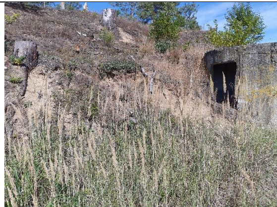
Abbildung 9: Blick auf Seitenbereich einer Bunkeranlage, der die sonnige Hanglage wiedergibt. Bild vom 21.09.23.
